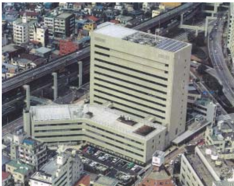
昭和 62 年 本庁舎北館竣工時の航空写真
