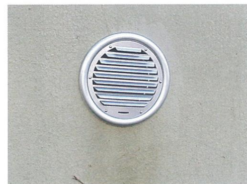
通気口の金属策が腐食した場合は、風通しを損なわないような材料でふさぎます。
