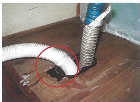
流しの下排水口まわりも、隙間をなくして出入りできないようにします。
