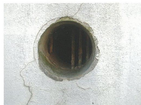
通気口の金属策が腐食した場合は、風通しを損なわないような材料でふさぎます。
