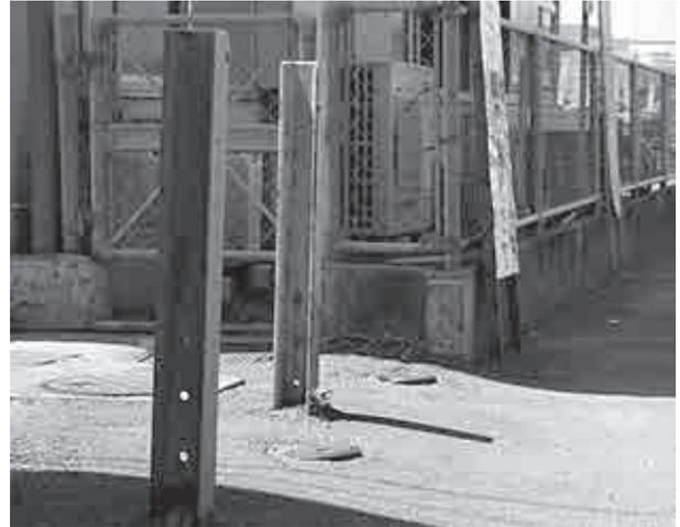
資料11 イギリス製レール(ダーリントン社製 駅構内の柵に利用されているもので客車庫から採取されたものと同種の刻印が見られ、「7」の刻印の直後で切断されている)
