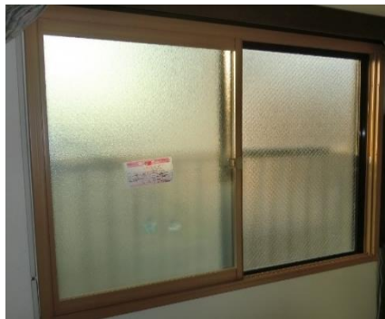
施工後写真例
