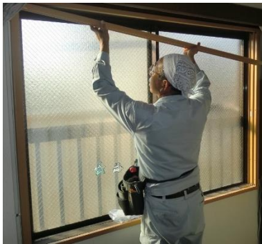
施工中写真例1
