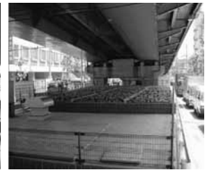
土壌大気浄化施設
