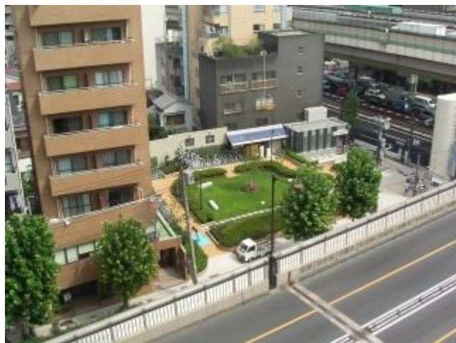
YUME パーク・大和町（上：整備前、下：整備後）
