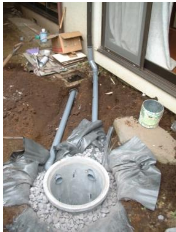
写真 4-10 雨水浸透枡の設置
