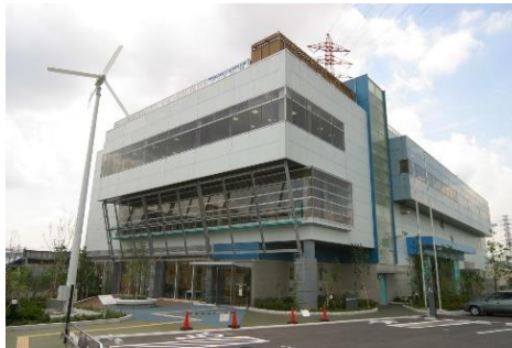
■ 板橋区立リサイクルプラザ
