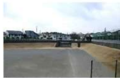
西東京市 向台調節池
