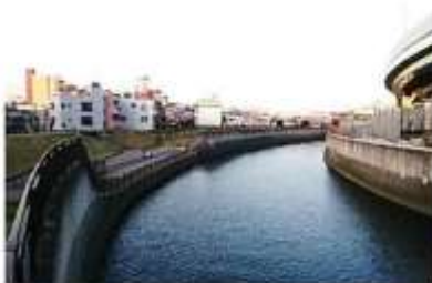
北区 あすか緑地付近 (高潮対策区間)
