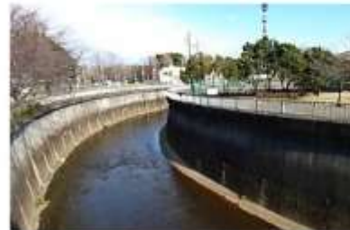
板橋区 栗原橋付近
