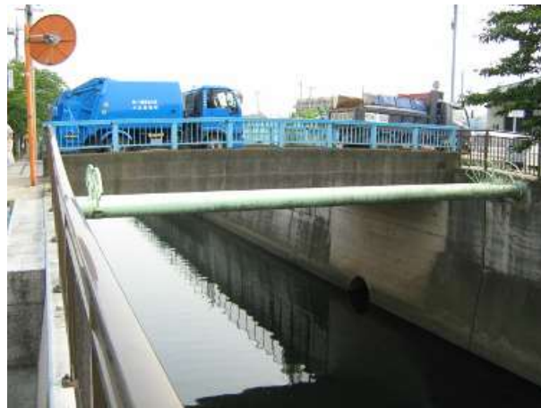
水道橋（和光市）
