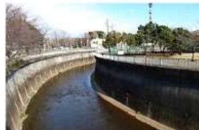
板橋区 栗原橋付近
