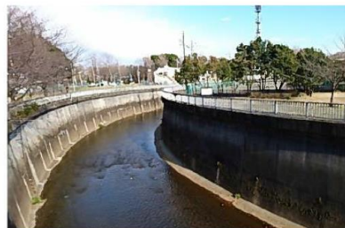
板橋区 栗原橋付近
