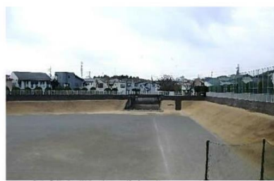
西東京市 向台調節池
