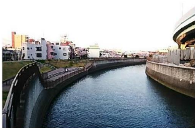
北区 あすか緑地付近 (高潮対策区間)
