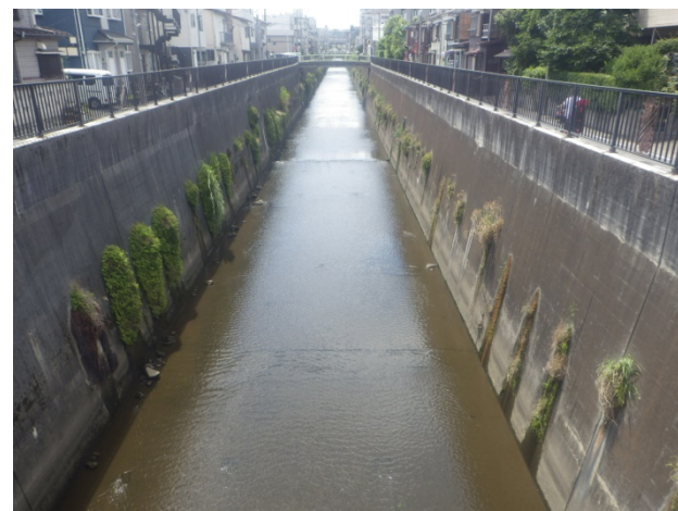
白子川 ②白藤橋付近 白藤橋上より上流方向
