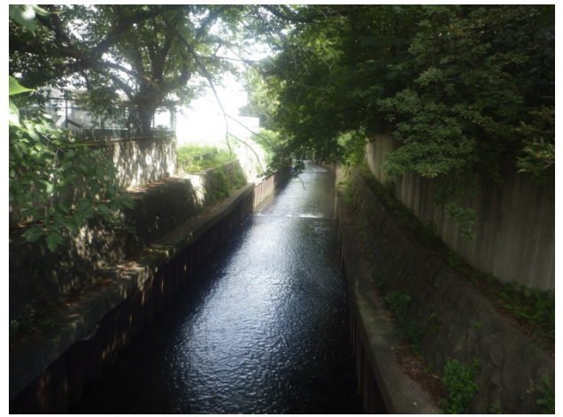
白子川 ①東埼橋上流付近 子安橋上より下流方向
