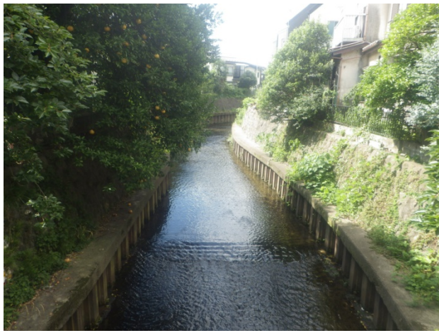
白子川 ①東埼橋上流付近 子安橋上より上流方向
