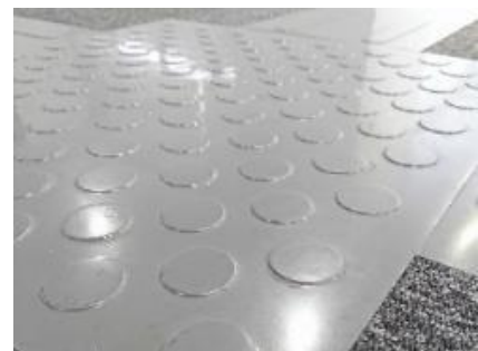
【南館の低突起ブロック】 屋内専用開発された突起の高さが 1mm のブロック。 白杖を滑らせた時に凹凸の振動が手に伝わり認識しやすい。
