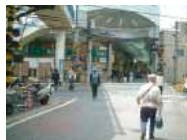
線路と道路の交差点部の安全確保が求められた踏切
