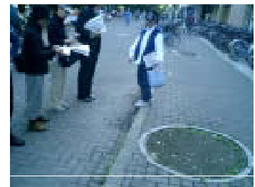
街路樹跡と駐輪により歩道幅員が狭くなっている団地内歩道(店舗前)
