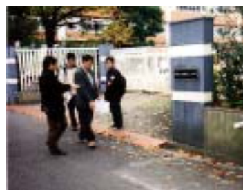
出入口の段差及び急勾配が指摘された小中学校出入口（避難所）
