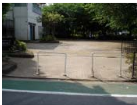
公園出入口部の段差
