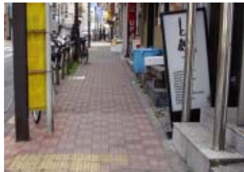
段差解消や自動ドアの設置が求められる店舗の出入口
