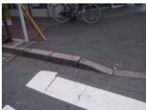
交差点部における横断歩道と切り下げ部のずれ
