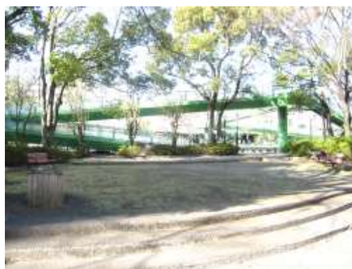
周囲との空間的な関係が弱い歩道橋(要点②(1))
