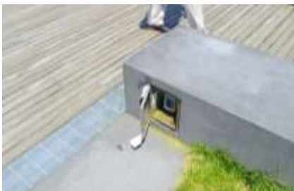
ファニチャーと一体的に整備された、イベント時に使用可能な電源設備
