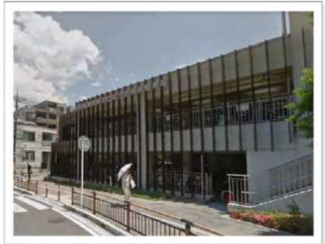
整備された駐車場
