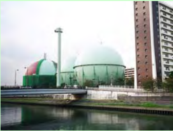
新河岸川沿いのガスタンク
