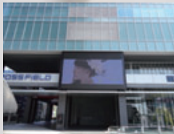
低層部に設置された LED ビジョンの例
