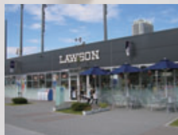
建物外観を活かすシンプルなサイン表示
