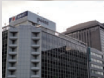
落ち着いた地色を基本とした屋上の広告塔
