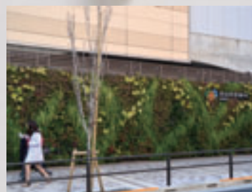
壁面緑化と屋外広告物を組み合わせた例
