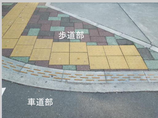
▲歩行者等が安全に通行できるように歩車境界の段差解消に配慮されている／板橋区(小豆沢)【⑤】
