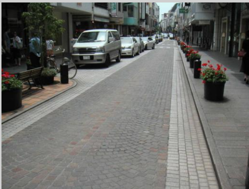
▲車道と歩道の仕上げや色彩の調和に配慮した魅力づくりとしている／横浜市【①】
