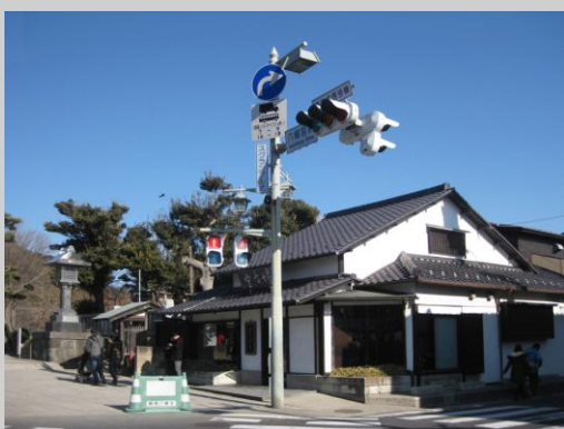
▲交差点部の信号や標識、照明灯を集約化している ／鎌倉市【③】
