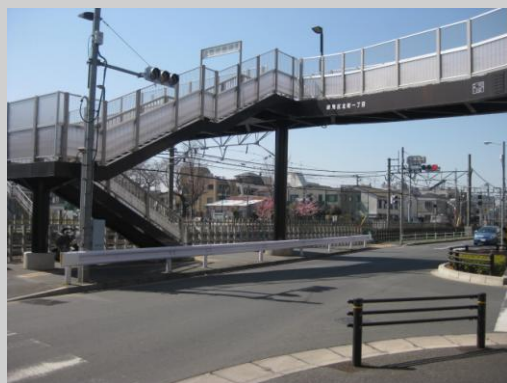
▲ 桁や柱などの構造部を落ち着いた色調とし、周辺の付帯施設とも調和している／練馬区【①】
