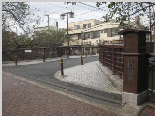
▲ 石神井川やその緑に溶け込むような橋りょうの防護柵や車止め、舗装の色彩に配慮している／板橋区(石神井川)【①】
