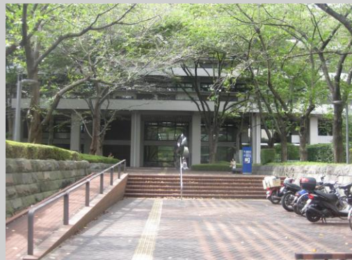
▲建物のエントランスに入りやすくし、スロープ、階段の一体的なデザインに配慮している／千代田区【⑤】
