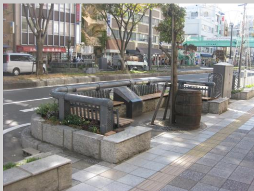
▲歩道の一部を膨らませ、休憩スペースを確保している ／さいたま市【①】
