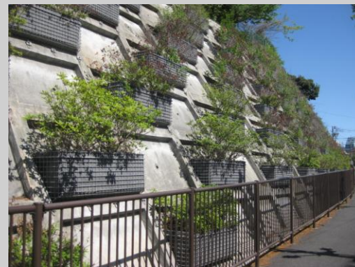
▲擁壁部を緑化し、圧迫感の軽減や潤いづくりに配慮されている ／板橋区(小豆沢)【④】
