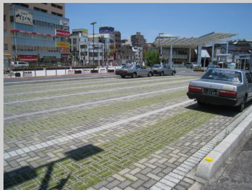
▲駅前のタクシースタンドの舗装に緑化用ブロックを採用し、潤いを与えている／朝霞市【① ②】
