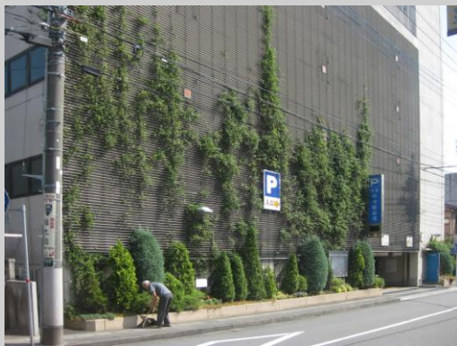
▲壁面緑化に配慮した駐車場としている／三島市【①】
