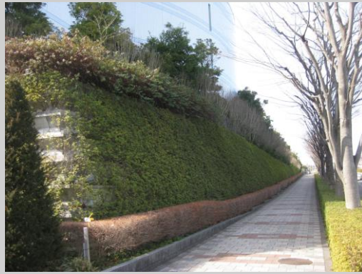
▲ 緑化用ブロックの擁壁面とし、上部に低木等を植栽している ／町田市【②】
