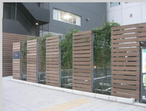
▲駐輪場を遮へいするため外周部フェンスをつる性植物で緑化している／品川区(民間施設)【① ②】
