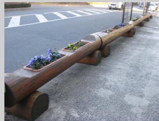
▲横断防止柵用として木材のプランターを設けている／和光市【④】
