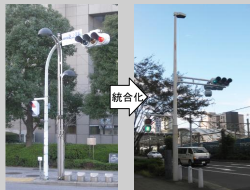
▲照明灯と信号機の統合化に配慮されている／さいたま市【④】
