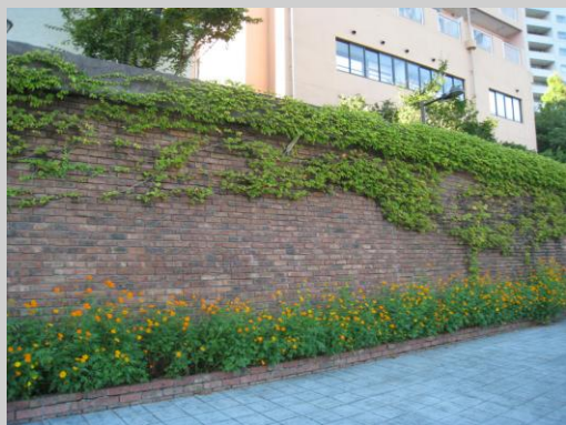
▲ 擁壁の仕上げとしてレンガ類を用いている ／中央区【②】
