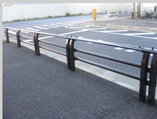
▲車道側に広がりを持たせるとともに防護柵のガイドラインに基づいた色としている／品川区【②】
