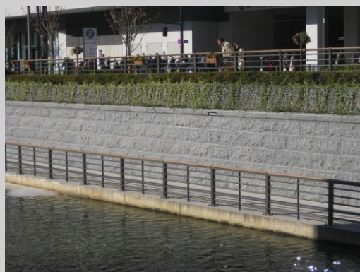
▲ 周辺の防護柵と調和したシンプルなデザインの擁壁とし、上部に緑を配し、潤いづくりに配慮している ／墨田区【① ②】
