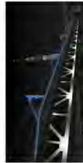
東武スカイツリーライン 隅田川橋梁ライトアップ事業 (提供:東武鉄道株式会社)
