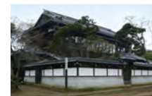
安養院の庫裡 C-3 旧前橋藩松平家の本邸。昭和4年に当時の麹町区から移築
