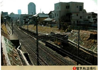
①電気軌道構内
