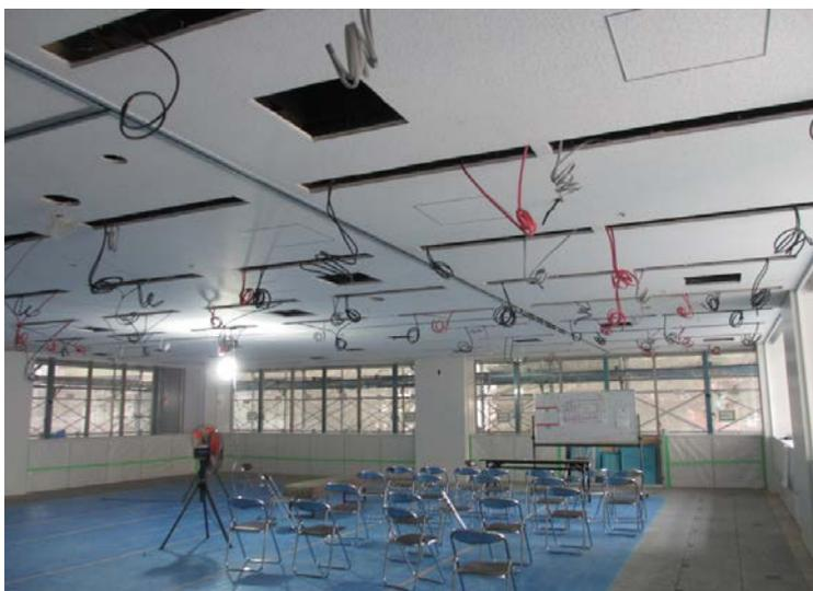
2階の内部工事の様子です。柱・壁の塗装工事と天井板の貼付けが完了し、床はOAフロアを設置しました。
