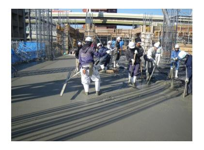
2階柱・壁と3階床のコンク リートを打設しています。 コンクリートはバイブレー ターを用い、締固めてから水 平に均します。
