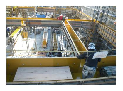
4階梁の型枠設置工事の状 況写真です。
