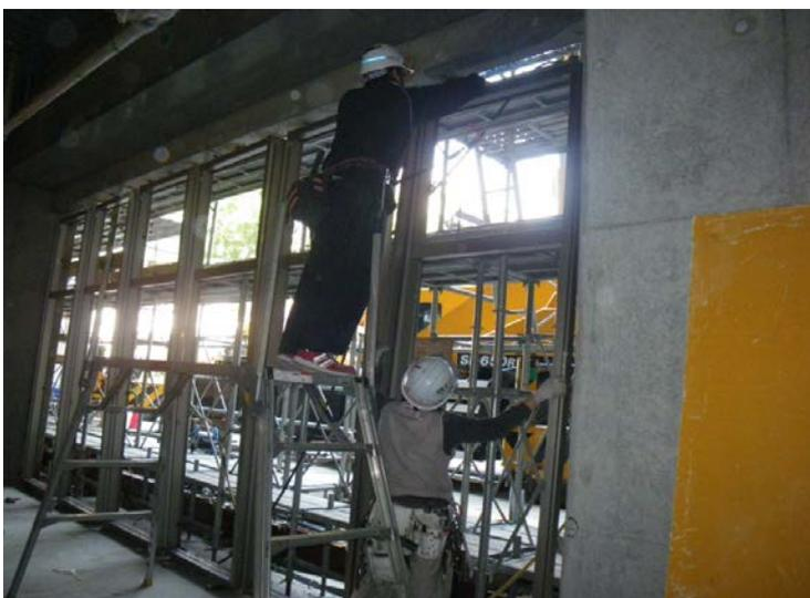
1階のアルミサッシ窓の取付状況です。
