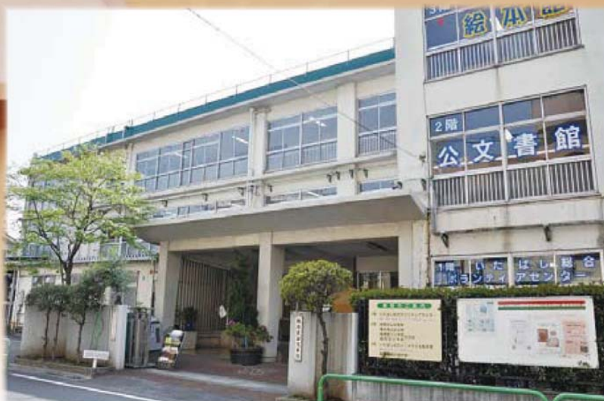
現在の公文書館（旧板橋第三小学校）
