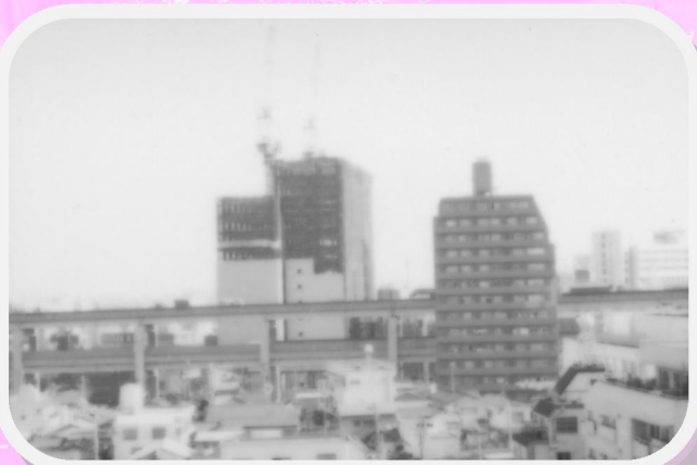
産文庁舎より工事中の庁舎をのぞむ (昭和61年)
