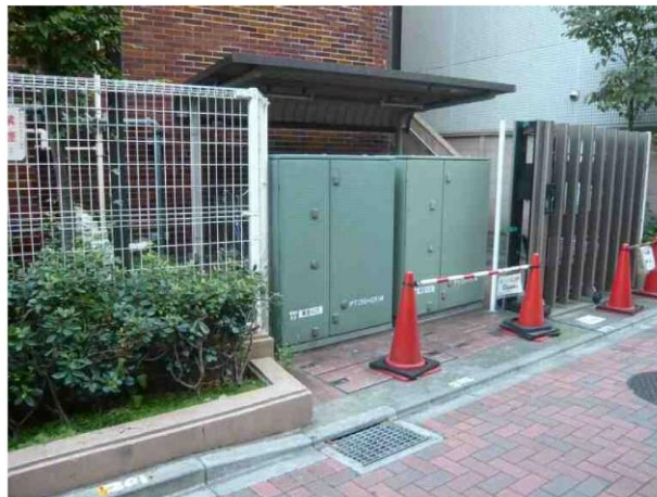
図 3-9 公共用地等への地上機器設置事例
