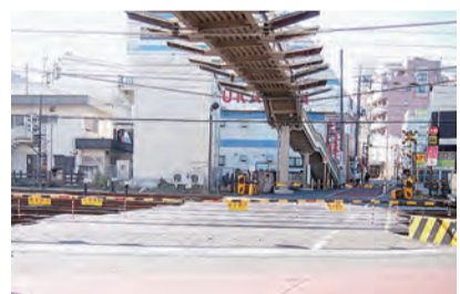
視察を行った成増駅付近の踏切
