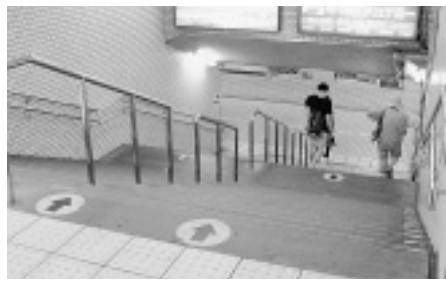
ときわ台駅北口側階段
