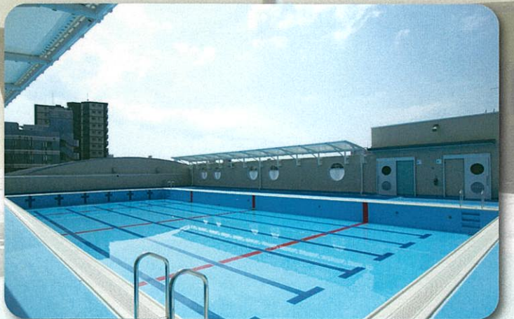
屋上プール(FRP製)
