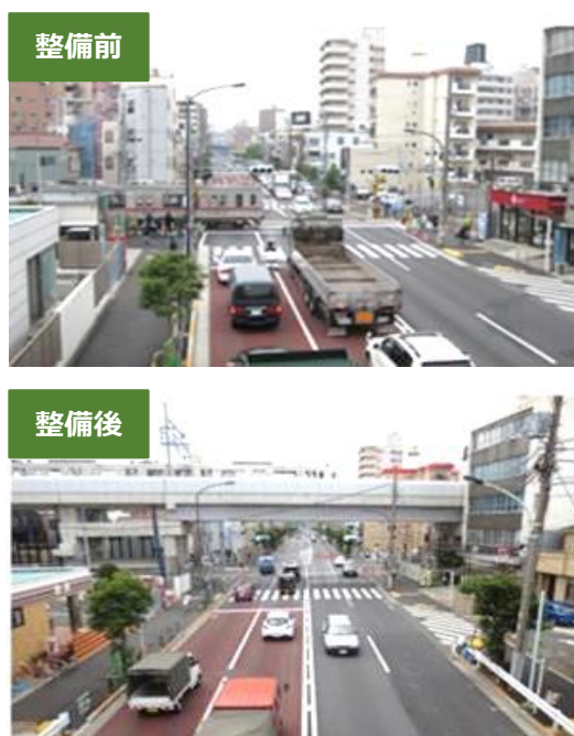
立体交差化の整備前後事例（京成押上線（押上駅～八広駅間）明治通り）
