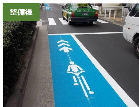
板橋区内における自転車専用レーンの整備前後の事例(前野町三丁目)
