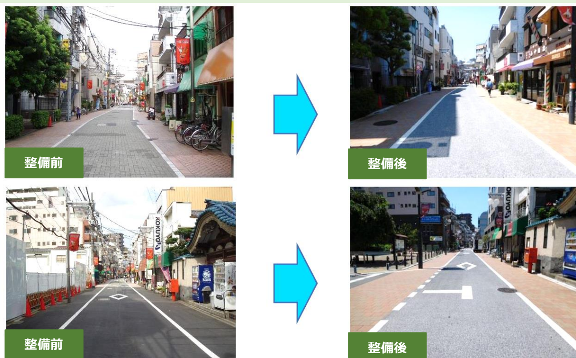
板橋区内の無電柱化による整備事例（板橋宿不動通り商店街）
