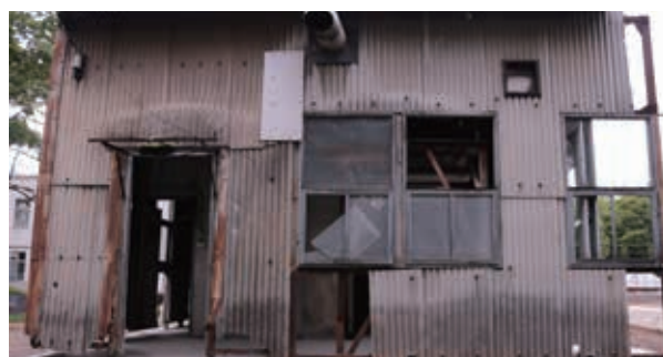
保存措置が必要な建造物（爆薬製造実験室）
