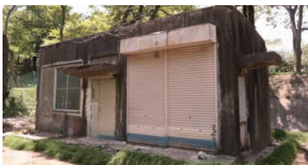
保存措置が必要な建造物（加温貯蔵室）
