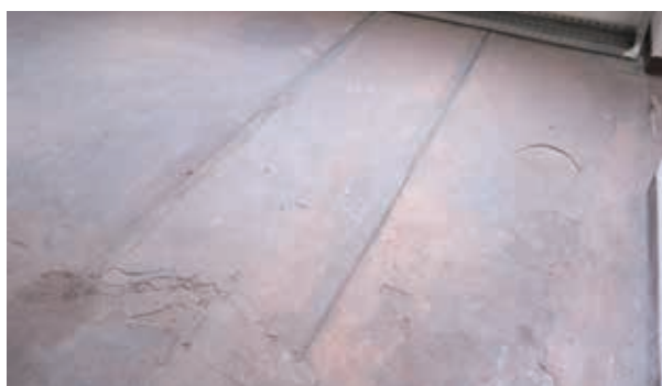
トロッキ軌道レール
