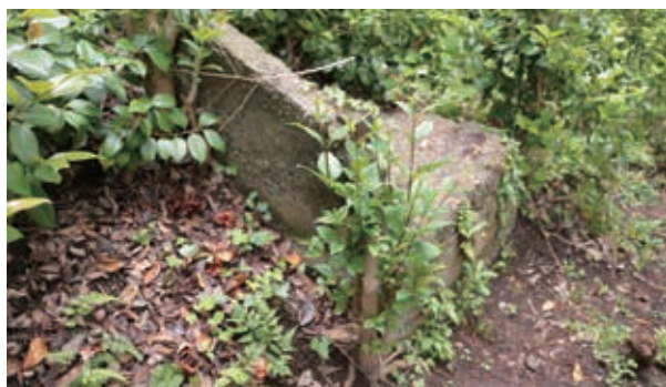
コンクリート構造物
