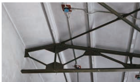
小屋組と母屋桁・接続リベット
