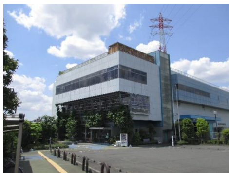
■ 板橋区立リサイクルプラザ
