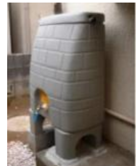
■ 雨水貯留タンク
