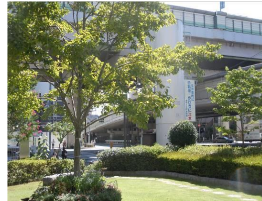
■光触媒（首都高速道路橋脚部）
