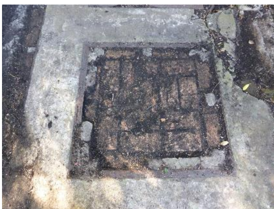
加温貯蔵室基礎部分の粘土状物質
