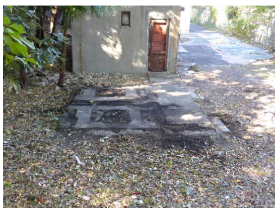
加温貯蔵室及び試験火薬仮置場
