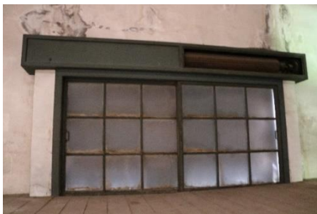
室内に残るシャッター
