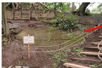
コンクリート擁壁
