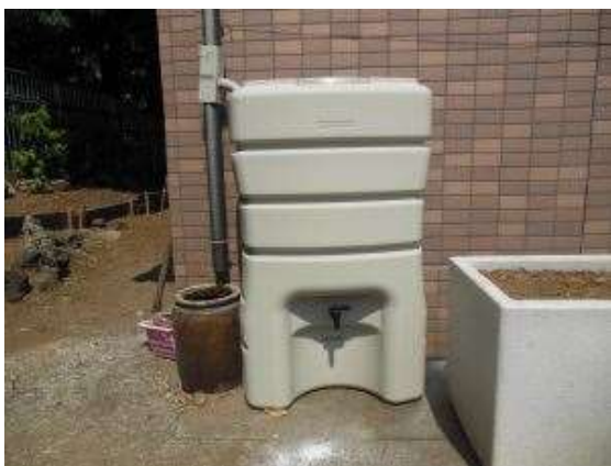
雨水タンク（治水対策）
