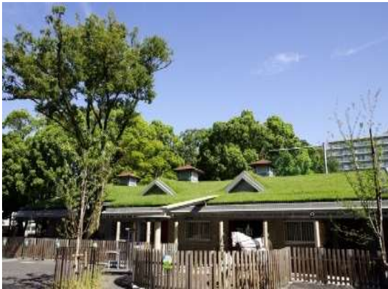
板橋こども動物園園舎の断熱化 (室温を一定に保ち、冷暖房機器の使用を抑制するため、改修工事に伴い、草屋根や壁面緑化を実施)
