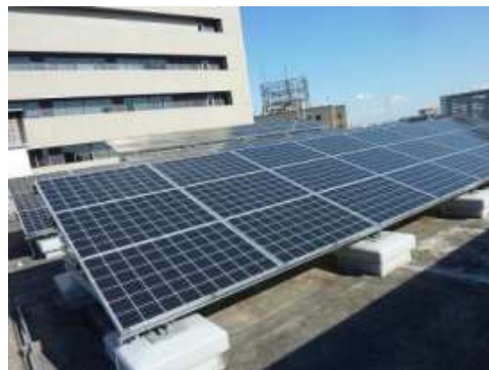
太陽光発電パネル(本庁舎)
