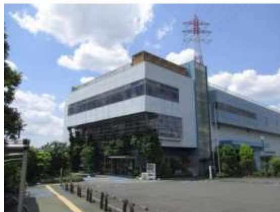
板橋区立リサイクルプラザ
