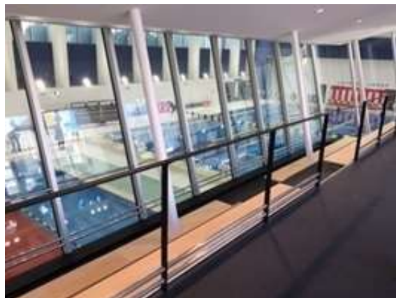
小豆沢体育館プール棟の地中熱利用 (プール棟共用部を中心に、地中熱を活用した空調システムを採用)
