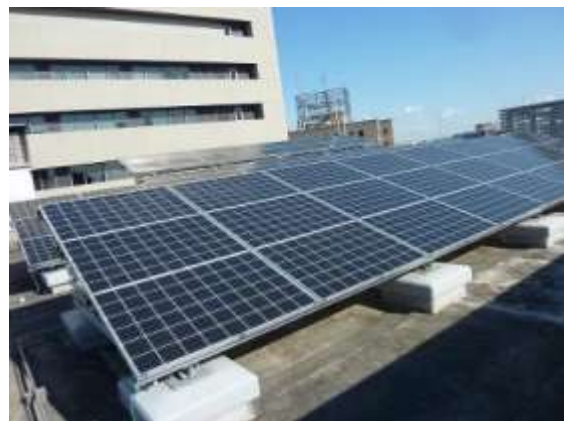
太陽光発電（本庁舎南館屋上）
