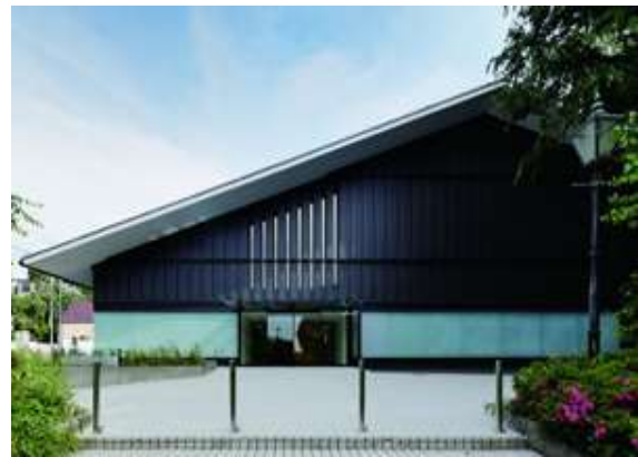
板橋区立美術館の大規模改修（長寿命化） (LED 照明を使用し、外断熱を施すことで、環境にも配慮した施設としてリニューアルオープン)
