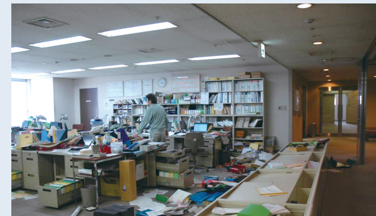
2011年3月11日 板橋区役所区議会事務局事務室の様子
