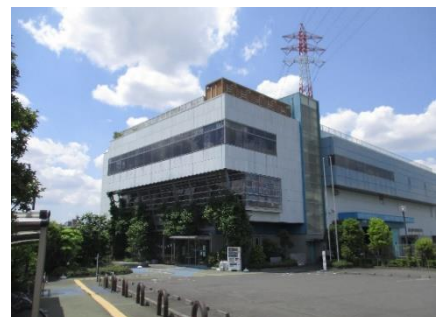
■ 板橋区立リサイクルプラザ
