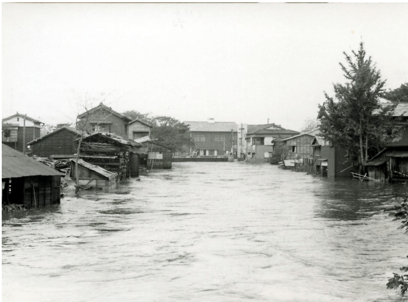
新板橋上流付近の浸水状況 【写真番号】 0048877
