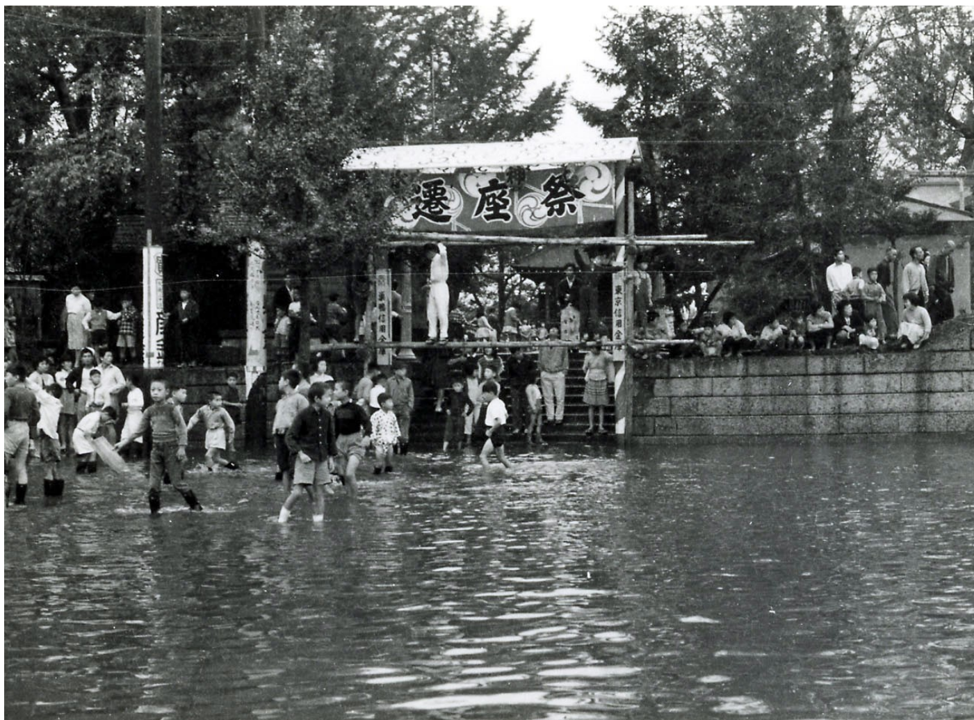
氷川神社付近の浸水状況 【写真番号】 0048307
