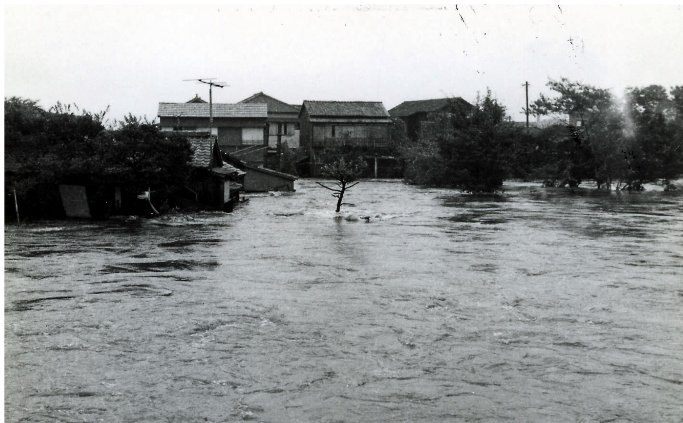
旧中山道 板橋付近の浸水状況 【写真番号】 0048310
