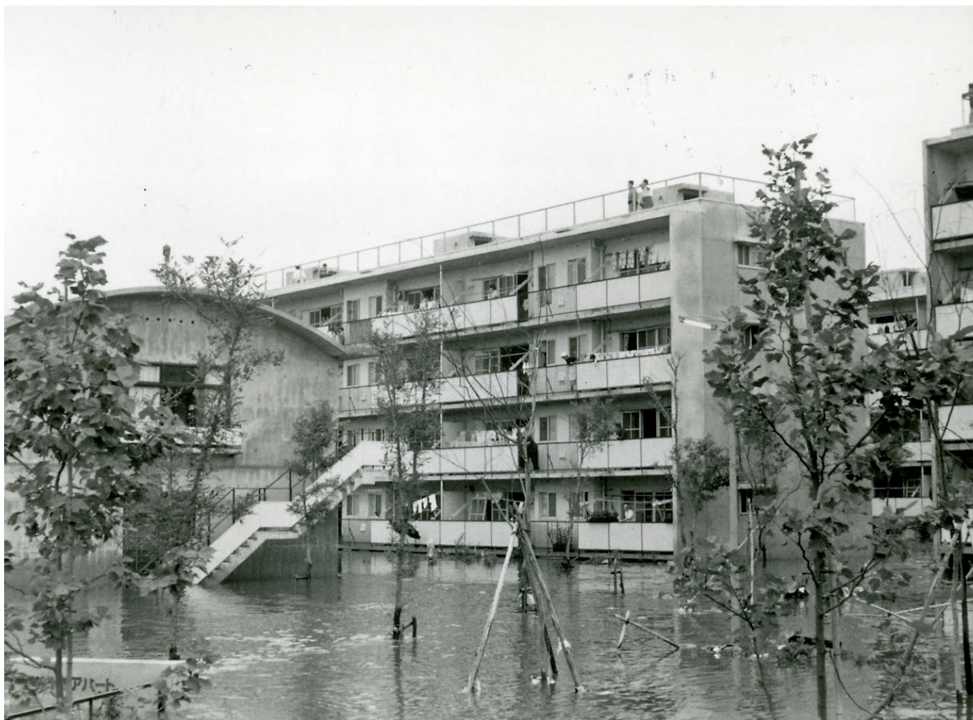
稲荷台団地付近の浸水状況 【写真番号】 P000456
