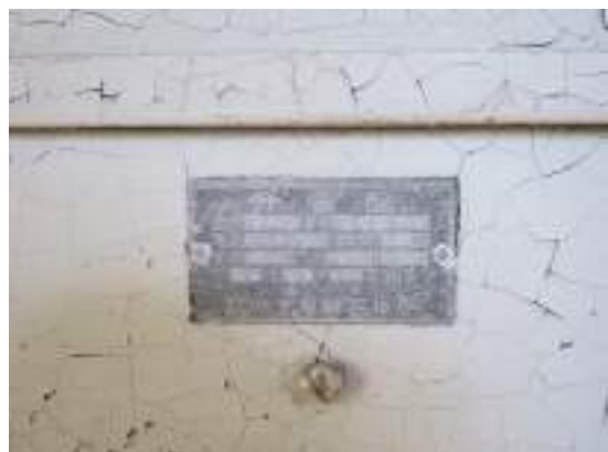
[図 39] 分電盤 昭和 16 年 10 月製造
