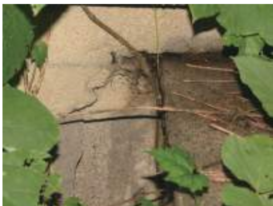
〔写真 1〕 テラスと外壁との取り合い
