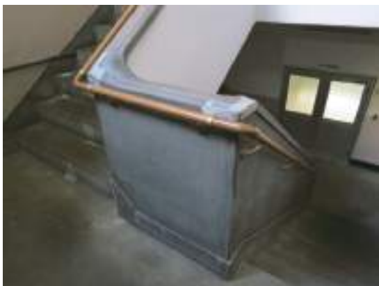
[図5] 階段踊り場の手摺壁
