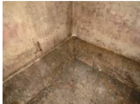
〔図 41〕 地下水槽の床端部納まり
