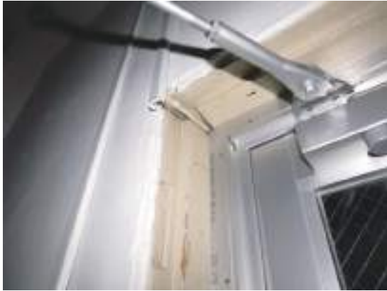
[図 11] 木製の建具枠跡
