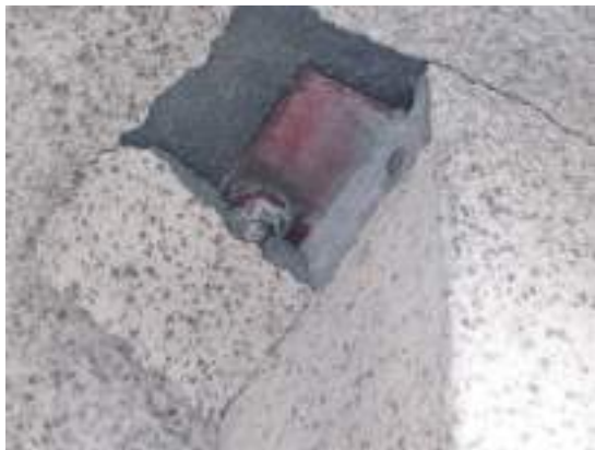
[写真3] ポーチと庇との取り合いの仕上げ欠損部分
