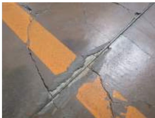
[図 25] 床の真鍮製の目地棒
