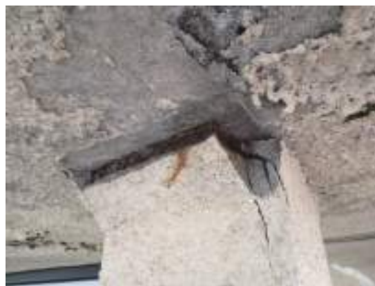
[写真3] ポーチと庇との取り合いの仕上げ欠損部分
