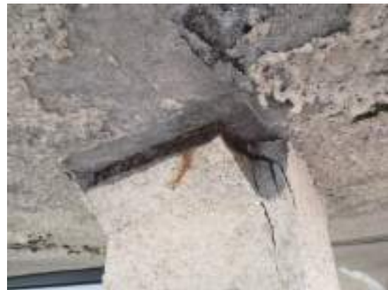
[写真3] ポーチと庇との取り合いの仕上げ欠損部分
