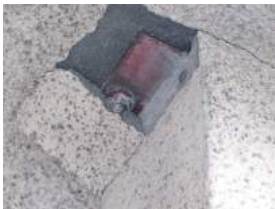
[写真3] ポーチと庇との取り合いの仕上げ欠損部分
