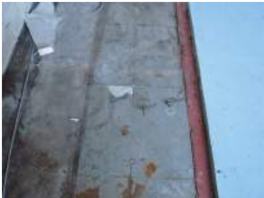
[図 26] 217号室の床リノリウム
