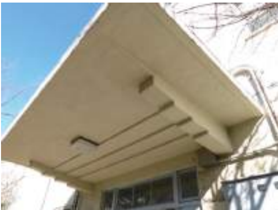
[図 36] 段差が設けられた持ち送り
