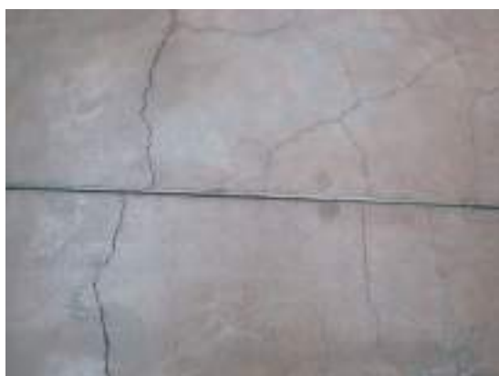
[図 24] 床の真鍮製の目地棒
