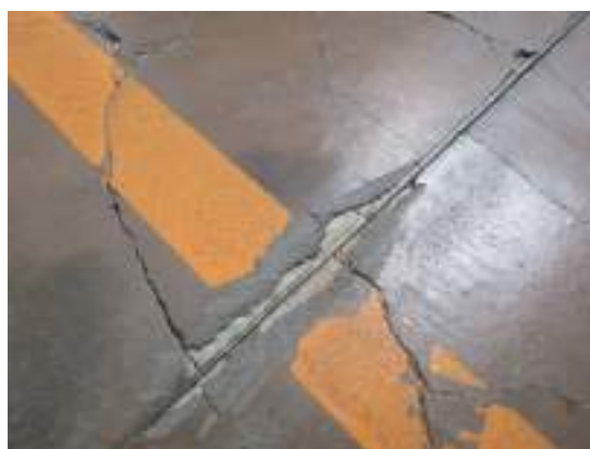
[図 25] 床の真鍮製の目地棒
