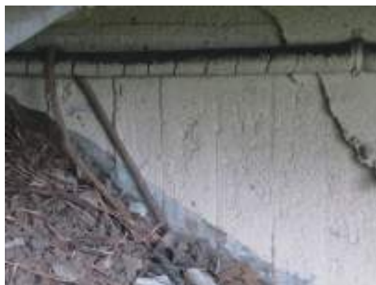
〔写真 2〕 テラス下の壁面にある縦板の型枠跡
