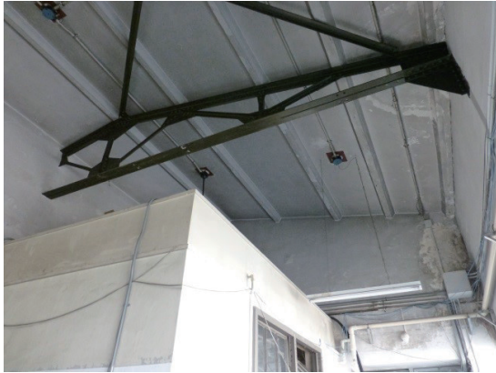
〔写真 35〕 D 棟小屋組
