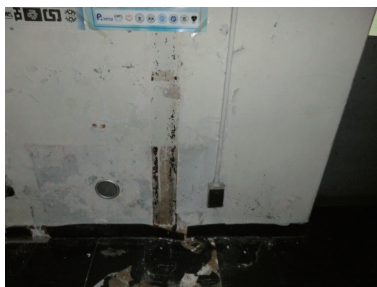
〔写真 32〕会議室内の H 型鋼の柱
