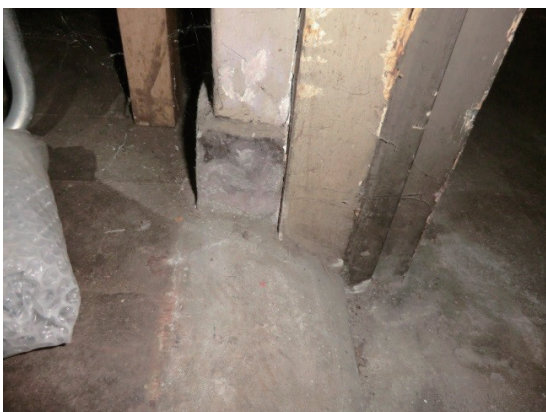
〔写真20〕 暗室と床と開口部取り合い
