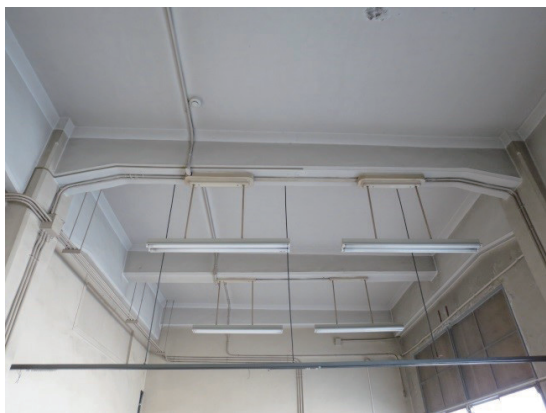
〔写真18〕 9号室天井
