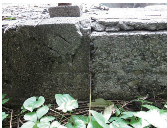
[写真 13] 左側バルコニー、右側外階段
