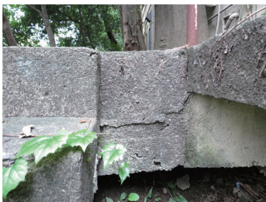
[写真 12] 左側外階段、右側バルコニー
