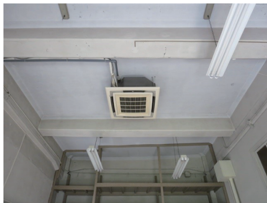
〔写真19〕 10号室天井
