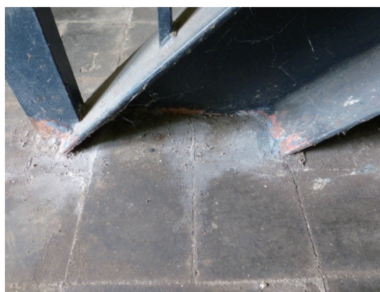
[写真 10] 階段のササラ桁と床との取り合い
