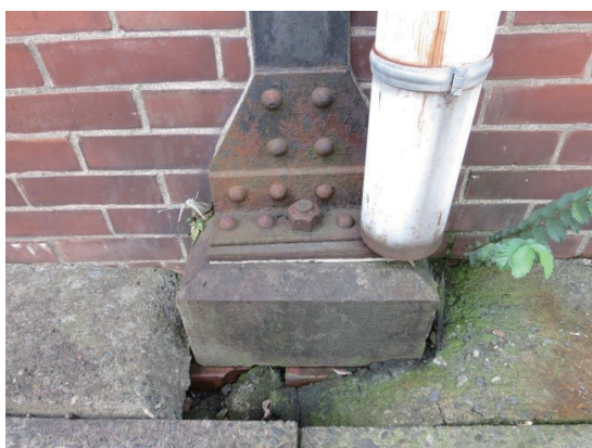
〔写真 31〕正面の H 型鋼の柱
