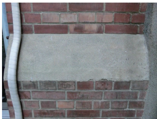
[写真 27] 背面外壁腰壁
