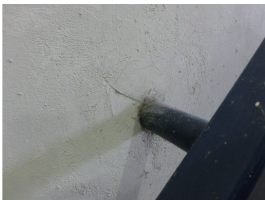
[写真 11] 階段手摺の壁面への取付け
