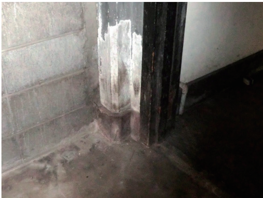
[写真 22] 廊下と10号室の壁面出隅部
