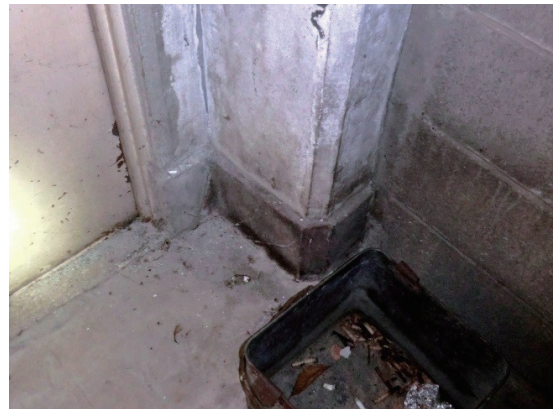
[写真 23] 廊下と宿直室壁面出隅部
