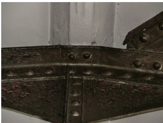
〔写真30〕 小屋組と母屋桁の接続部
