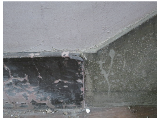
〔写真 40〕 火薬研究所 階段取り合い巾木
