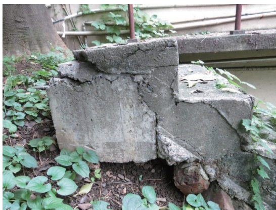
[写真 14] 階段の上塗り
