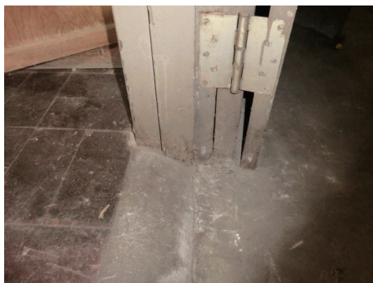
〔写真21〕 9号室と床と開口部取り合い
